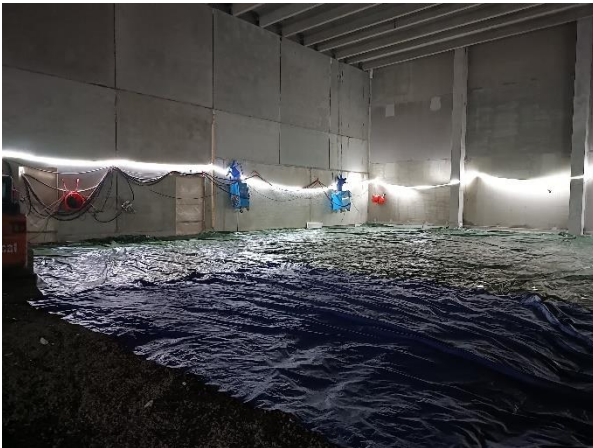
-Maan sulatus liikuntasalissa. Perästä jatkuu maatyöt ja alapohjatyöt.
