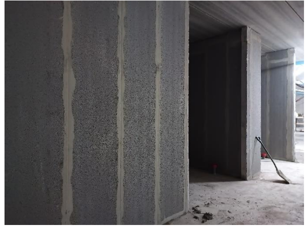
-Väliseinäasennukset aloitettu (lohko 2, kerros 1) ylä-taso.
