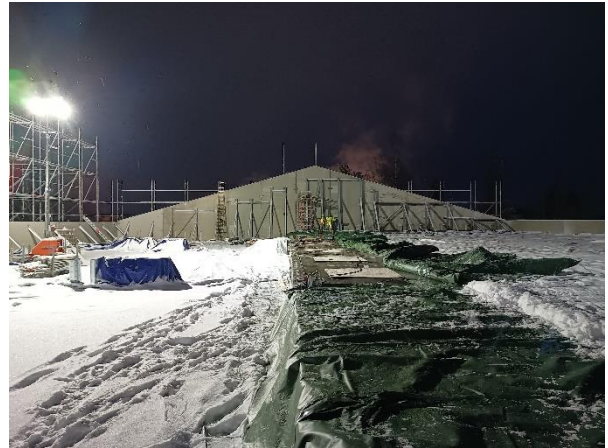
-Vesikaton kuorielementit asennettu (lohko 1, vesikatto). Perästä seuraa sääsuoja-asennus ja vesikaton puurakenteet.
